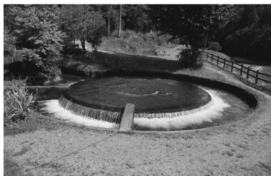
通潤橋と円形分水
