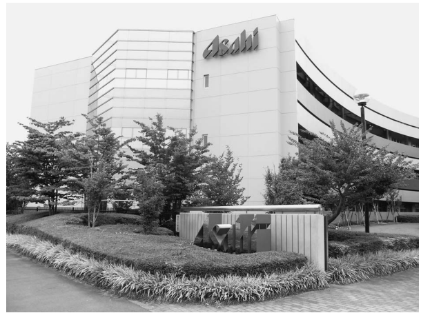
写真1 アサヒビール株式会社研究開発センター外観
